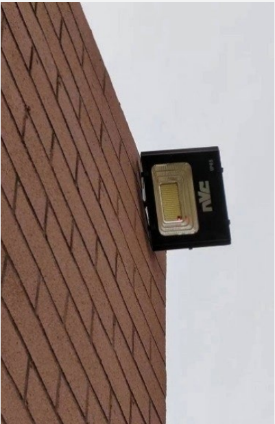
江苏公司太阳能道路照明系统
