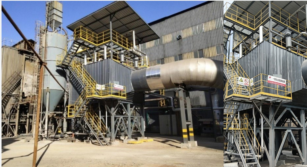
改造后的换热器设备
